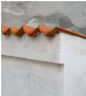
Murafdækning. Gl. dansk vingetegl lagt i cementmørtel.
