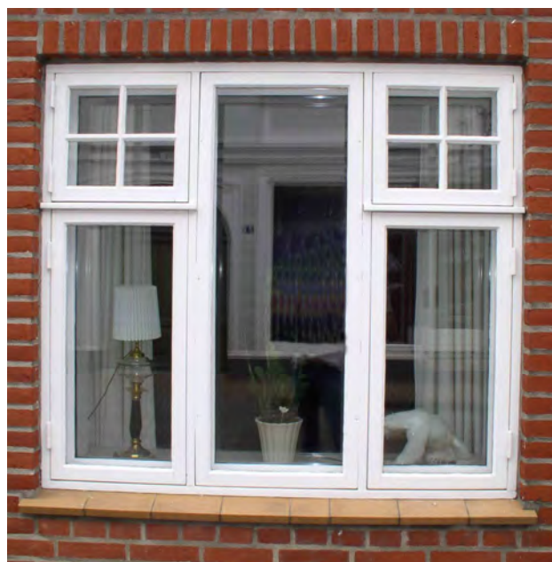
Eksempel på stort vindue, der hører til kategorien dannebrogsvinduer.
