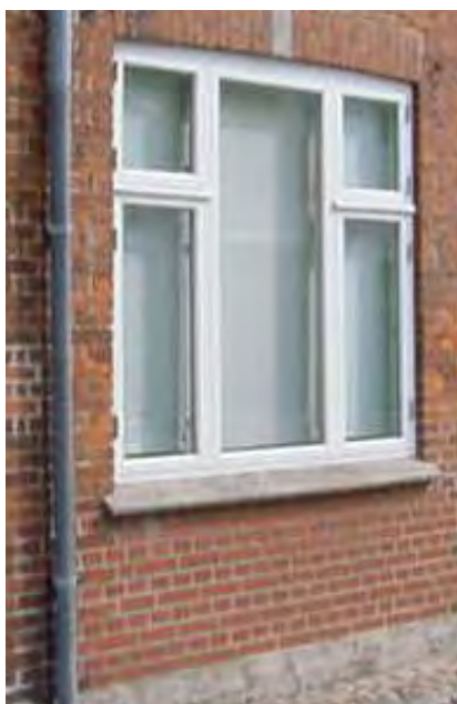
Eksempel på stort vindue, der hører til kategorien dannebrogsvinduer.
