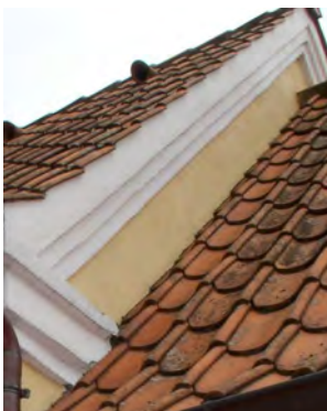
Afslutning uden udvendig synlig inddækning.
