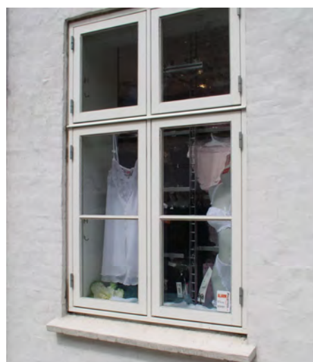
Dannebrogsvindue med tynd sprosse i nederste rundefelt.
